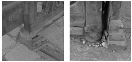
シェーンブルン宮殿の正門の軸受け金物（右）と門扉の先端の戸車前に付けられた刷毛（左）
